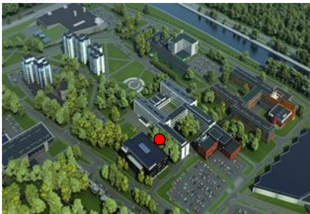
13.attēls Pārbūvējamās ēkas Ķīpsalas ielā 6A, Rīgā, novietne
