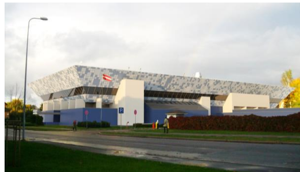
30.attēls Skats uz peldbaseina ēku Ķīpsalas ielā 5, Rīgā, no Ķīpsalas ielas puses
