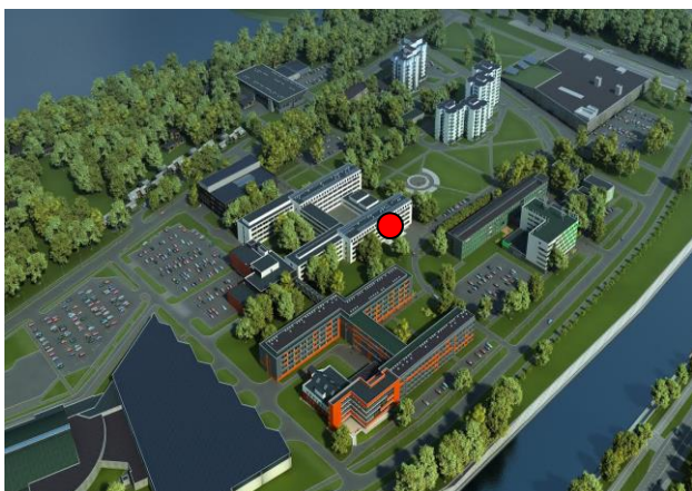
18.attēls Pārbūvējamās ēkas Ķīpsalas ielā 6B, Rīgā, novietne
